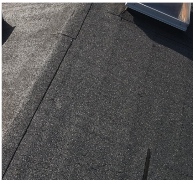
Blok A - Især på den syd-vestvendte del af taget er tagpapen i dårlig stand. På billedet kan man ane "revnerne" i pappen.
