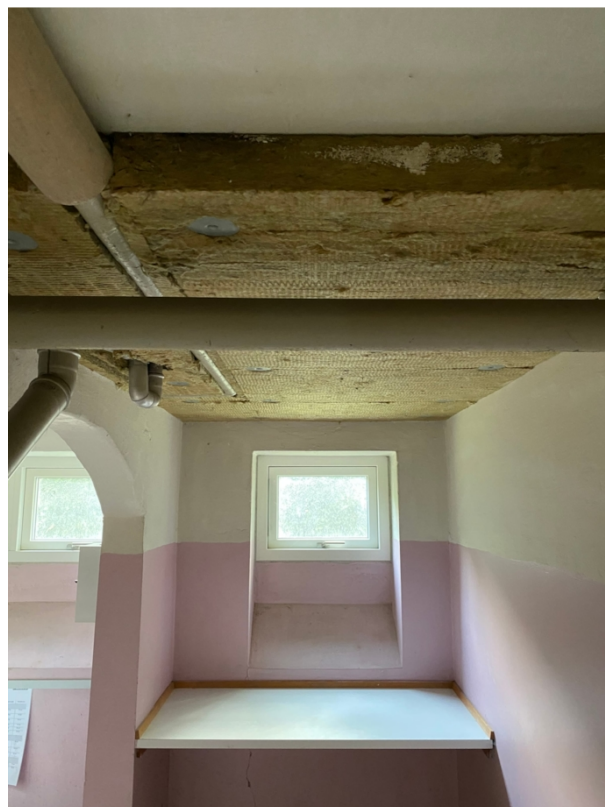
Isolering på kælderloft under badeværelse
