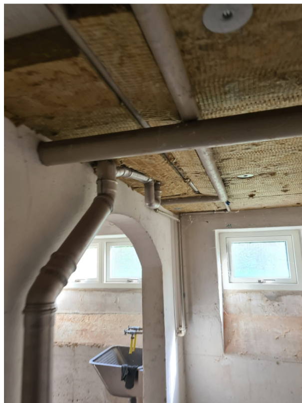
Partielt udskiftet faldstamme i kæder
