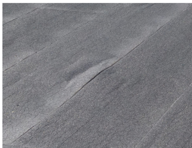
Samling mellem tagpapbaner som ser ud til at have sluppet.
