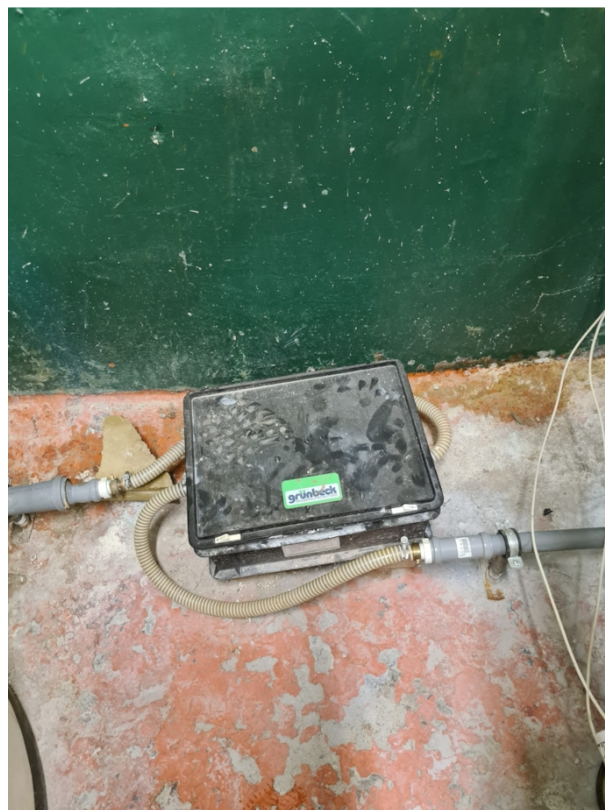
Neutraliseringsboks for gaskedel
