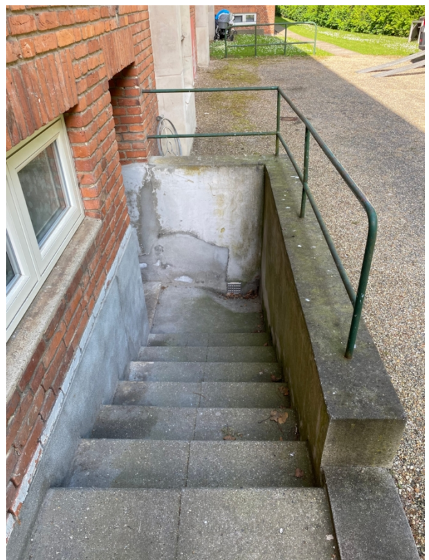
Kældertrappe hvor der er udført reparationer på vange
