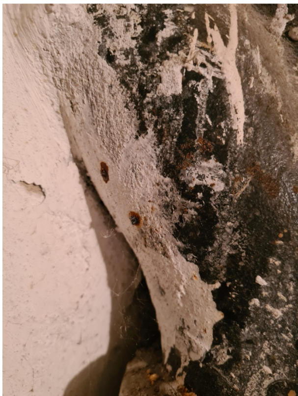
Gammel faldstamme i kælder med tæring
