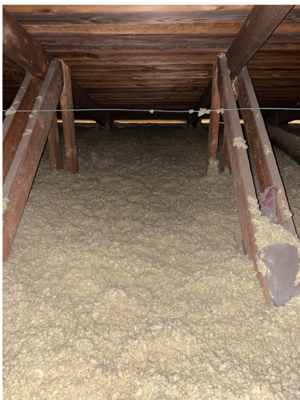
Etageadskillelsen mod loft er isoleret ved udlagt granulat
