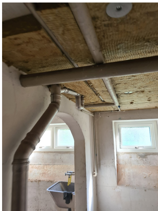
Partielt udskiftet faldstamme i kæder
